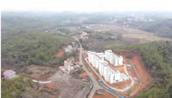
图 3.4-1 东侧：居民自建住宅
