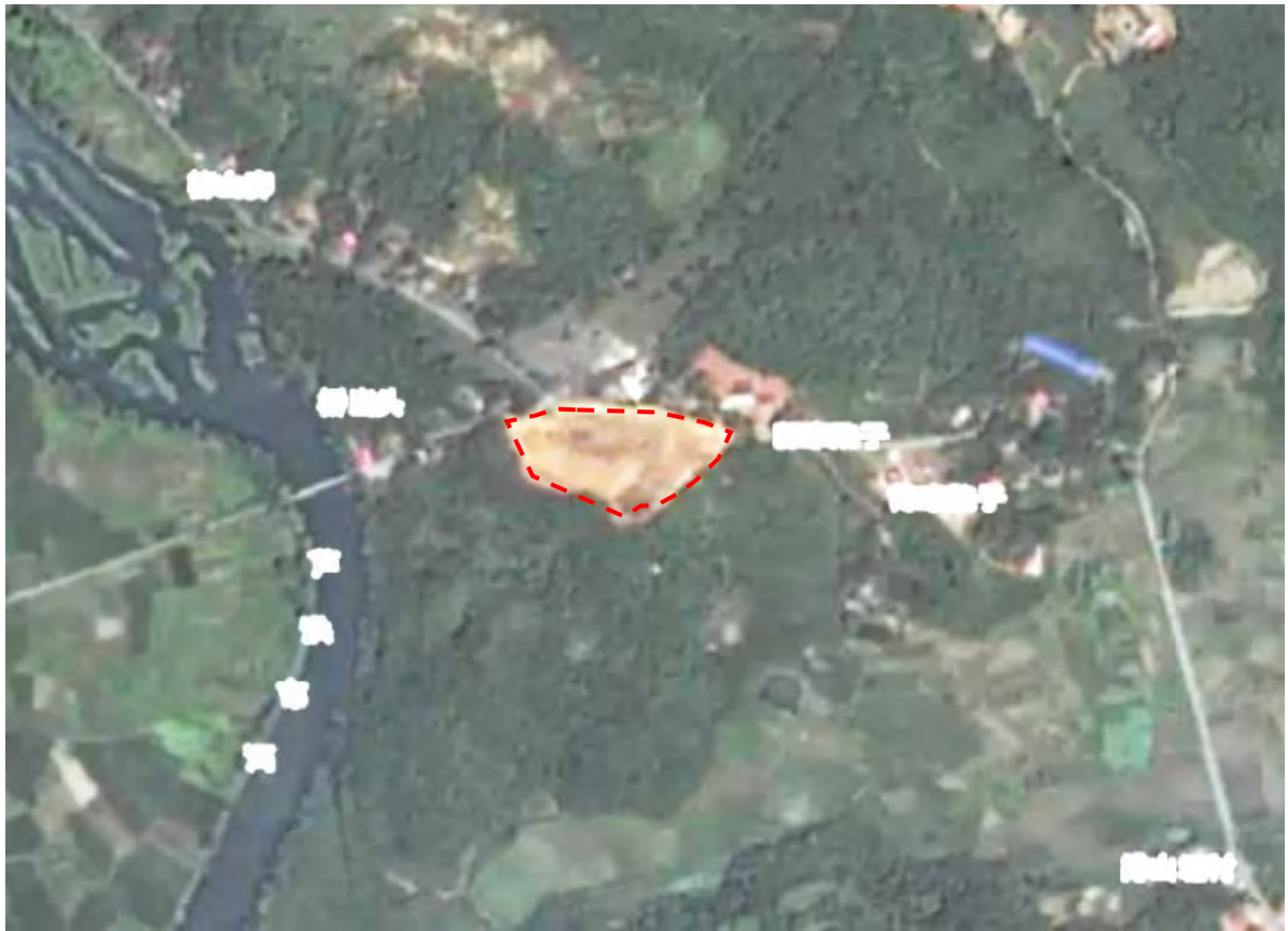
图 3.3-11 地块历史卫星图（2020 年 8 月）：场地完成开挖平整工作
