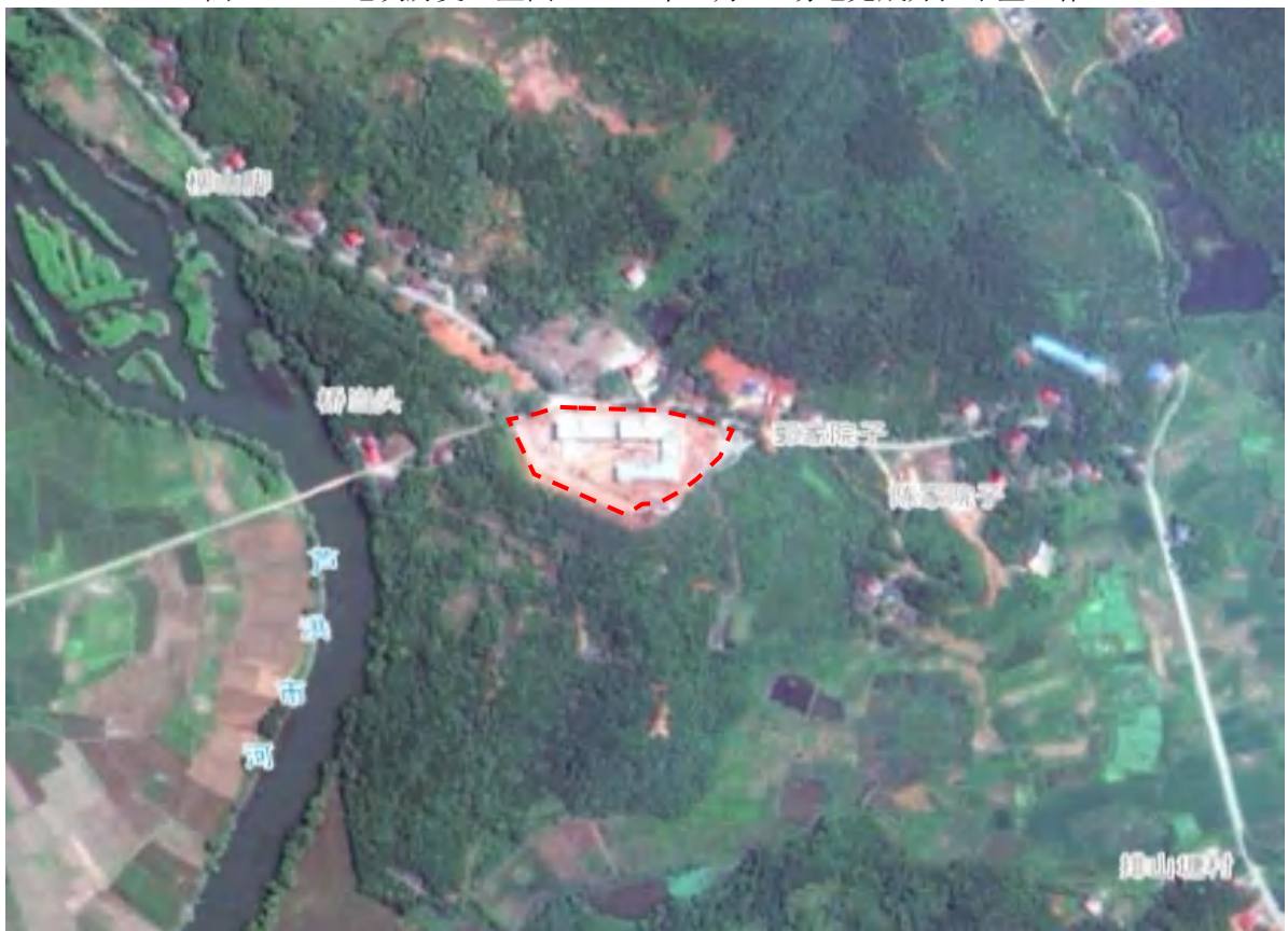
图 3.3-12 地块历史卫星图（2021 年 7 月）：项目主体逐步施工
