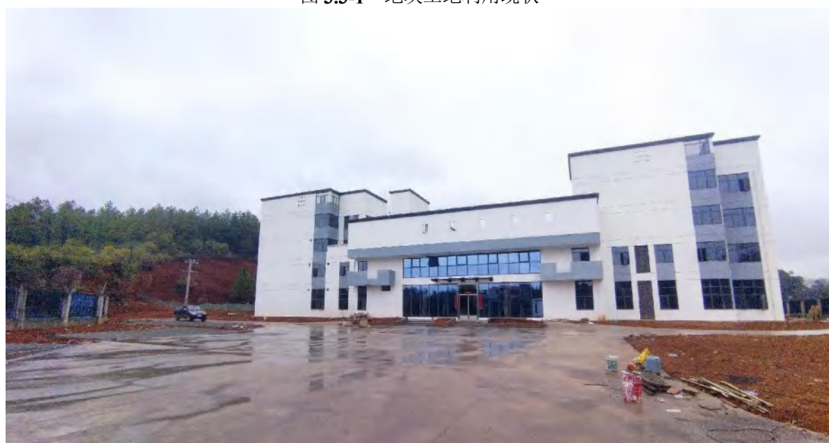
图 3.3-2 主体工程已近完工
